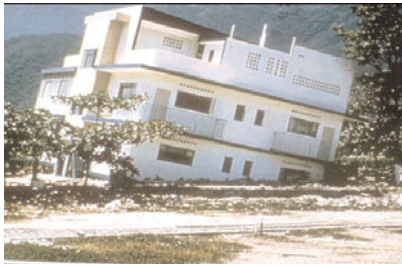
Fig. 22 - Immeuble enfoncé dans le sol après liquéfaction de ce dernier (séisme de Caracas, Venezuela, 1967)
