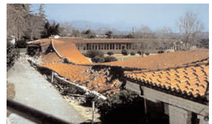
a) Charpente lourde portée par des murs en maçonnerie non chaînée
